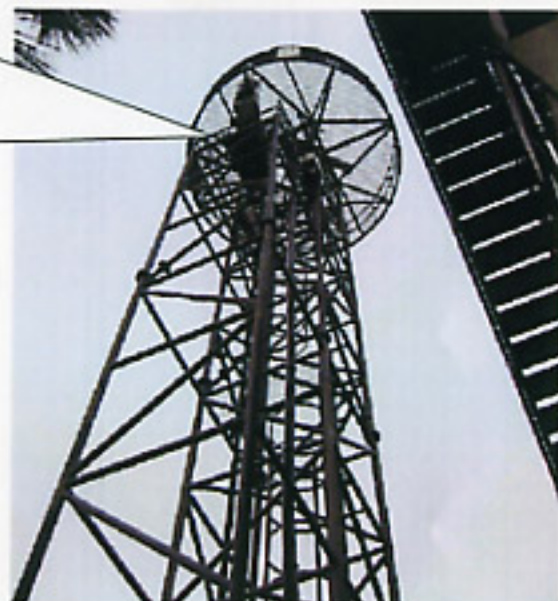
カメラ設置鉄塔
