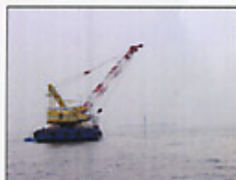
【工事・安全状況把握】
